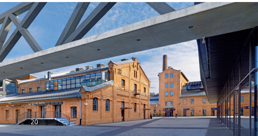
Centrum Praskie Koneser Warszawa
